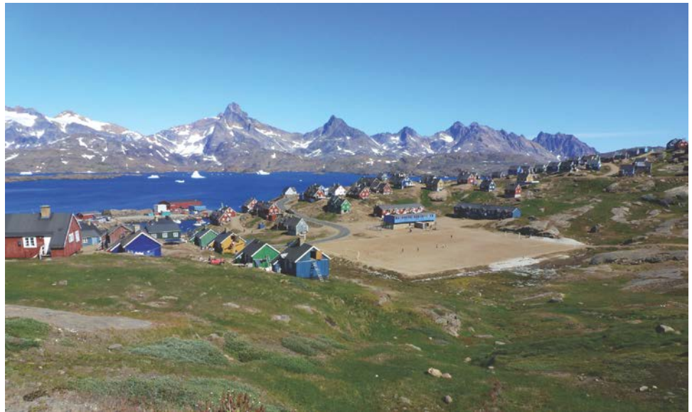
Figur 5, Billedet viser de eksisterende boliger, der omgiver området. Den lyseblå bygning ved boldbanen er den nedlagte institution, der kan nedrives.
