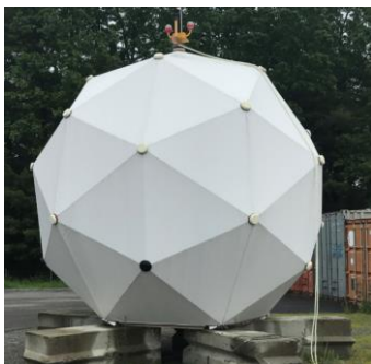
Figur 7: Parabolantennen fremstår som en hvid prismatisk kugle med en diameter på 6,4 meter og en højde på lidt over 5 meter. Antennen monteres på gitterkonstruktion udført i galvaniseret stål. Samlet antennehøjde på omkring 8 meter over terræn.
