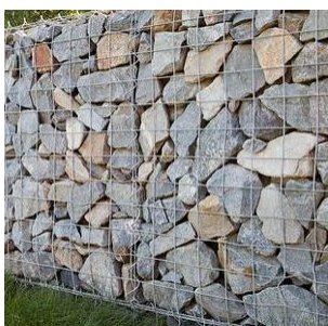
Gabion mur langs vej udført med lokale stenskærver
