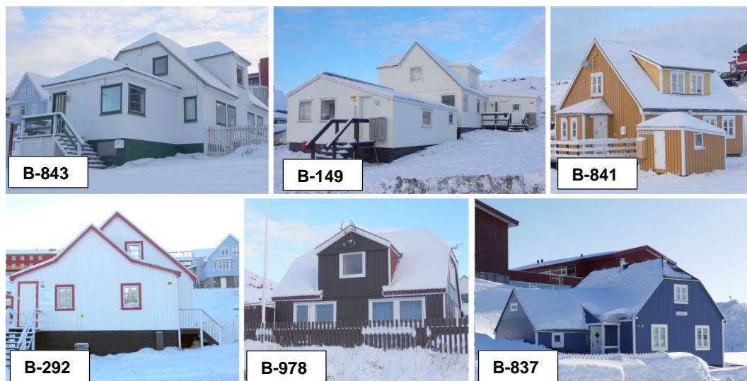
Fig. 2: De bevaringsværdige bygninger i området: B-843, B-149, B-841, B-292, B-978 og B-837
