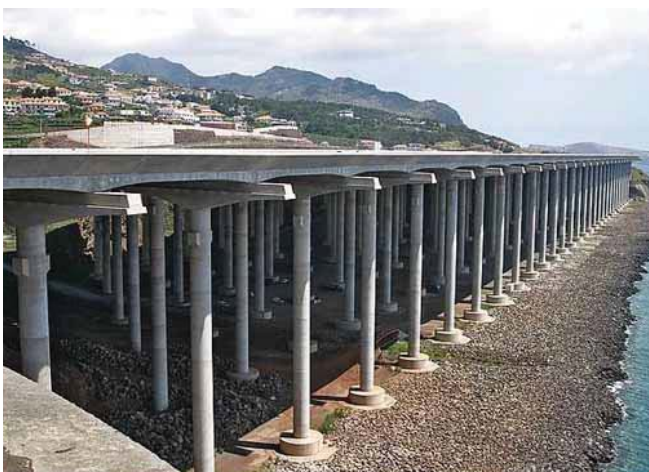
Fig. 11 Eksempel på landingsbane på et søjlefundament.
