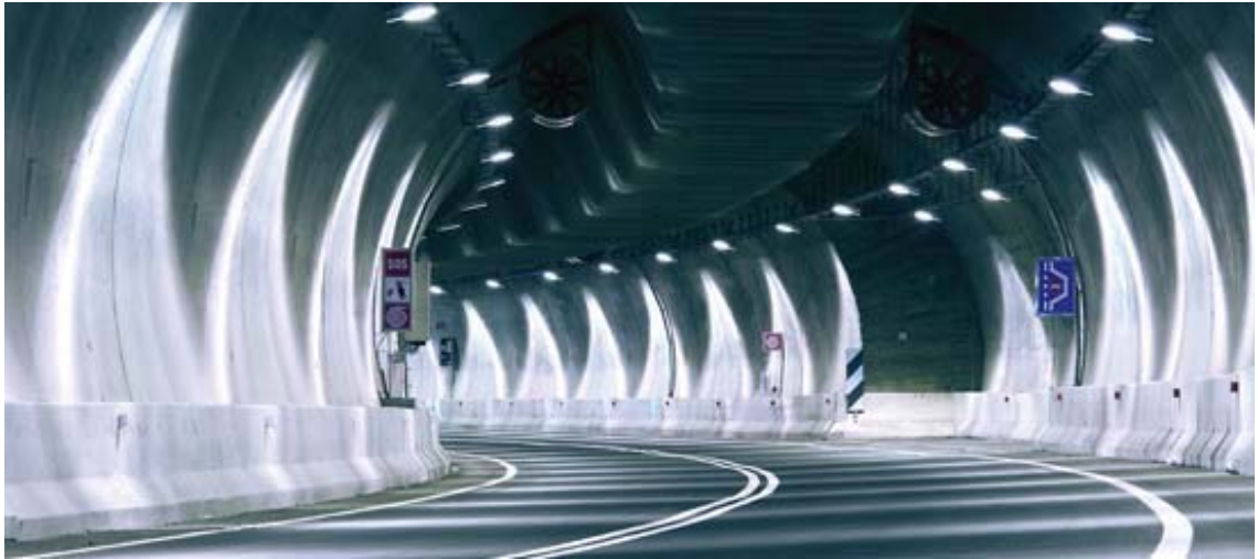
Fig. 10 Brug af lys i tunnel
