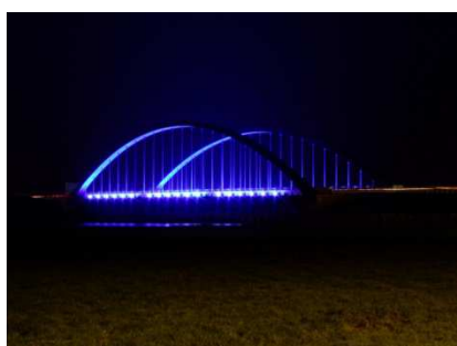
Fig. 14. Toome Bridge, Irland
