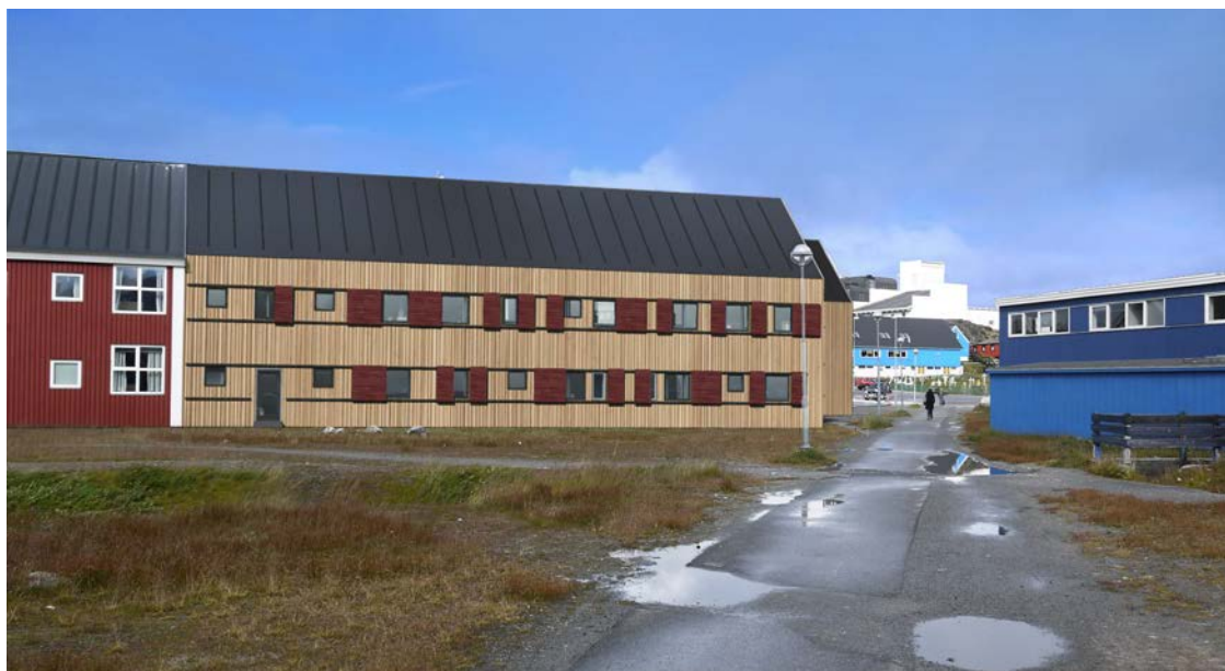
Fig. 7. Udvidelse af B-2121, set fra Stephanson sti, "Den historiske akse". Facader tænkes beklædt med lodret bræddebeklædning i ubehandlet træ, en træbeklædning som over tid vil blive lysere. Der er ved materialevalg og farvesætning af tilbygningen hentet referencer i den nuværende bygnings rødmaledede træfacader.
