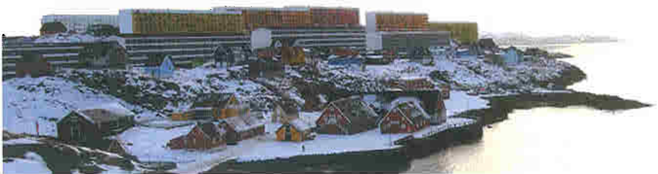
Fig. 6 Vejledende billedmanipulation: De eksisterende altaner på de høje blokke er blevet malede
