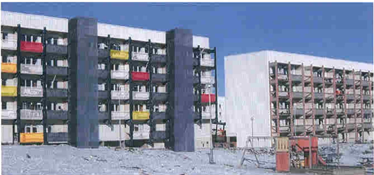
Fig. 16 Vejledende billedmanipulation: Elevatorer og nye altaner udført i stål og glas.
