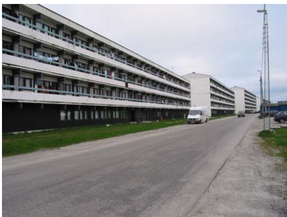
Figur 1 | Eksisterende blokke langs Tuapannguit
